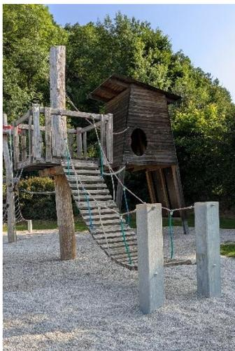
Bild links: Um weitere teure Sanierungsarbeiten in Zukunft zu vermeiden, wurden die desolaten Holzsteher durch zwei Metallsteher ersetzt
