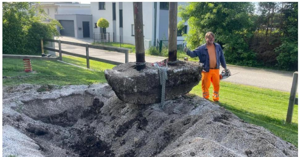
Bild oben: Die Holzsteher wurden samt Fundament mit dem Bagger entsorgt
